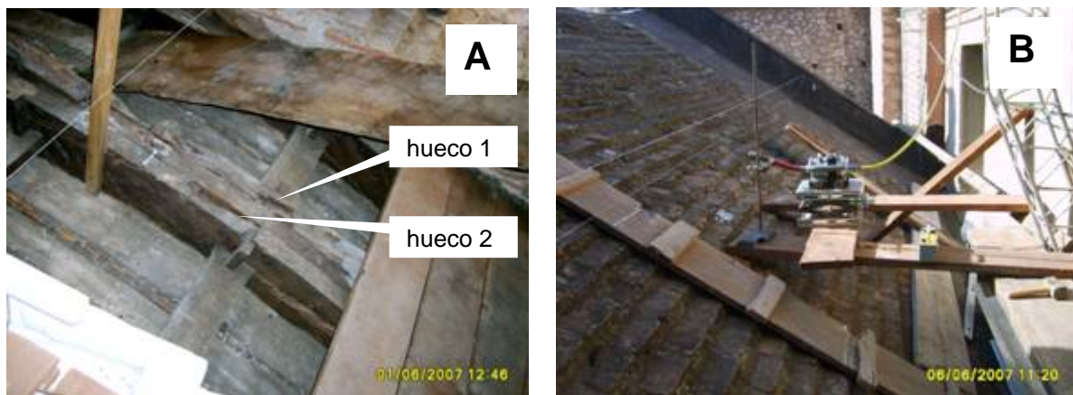
Figura 1. A. Se muestra la sección del techo donde se removieron las tejas y tablones. Se señalan los huecos 1 y 2 de la viga de la cabriada #12. B. Medición #14 mostrando la ubicación de la fuente radiactiva.
